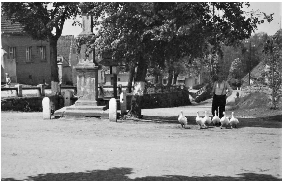
Křižovatka U Křížku na začátku 50. let. Klidné místo uprostřed obce. Pan Hausner žene domů husy od řeky. Křížek byl postaven pravděpodobně v polovině 19.století. Konaly se zde církevní slavnosti. Již v roce 1922 se uvažovalo o odstranění, protože začala ve vsi fungovat autobusová doprava.
