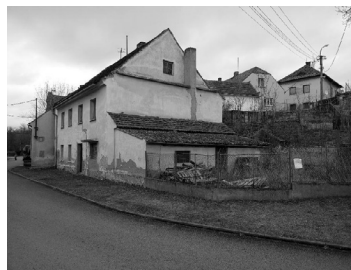
Bývalá židovská škola a prostor po zbourané synagoze v roce 2022
